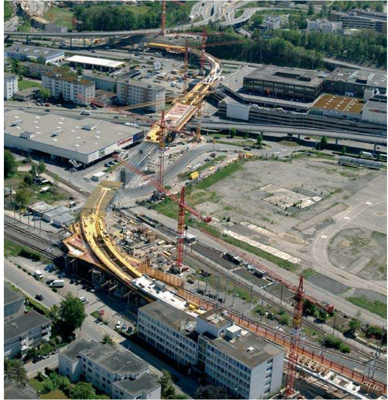
Fig. 2 Brückenbau in städtischer Umgebung (© Simon Vogt). Bridge construction in urban environment (© Simon Vogt).
