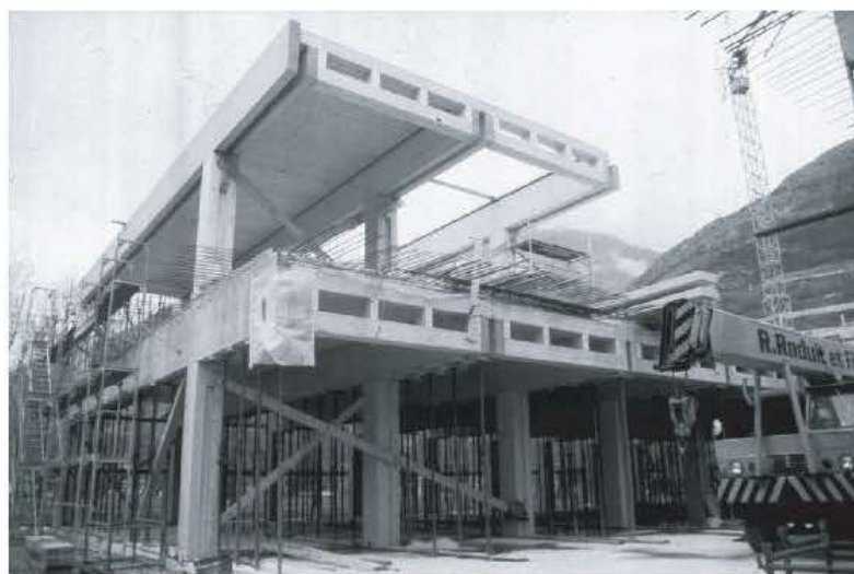
(a) Montage des poutres principales et transversales en travée centrale.
