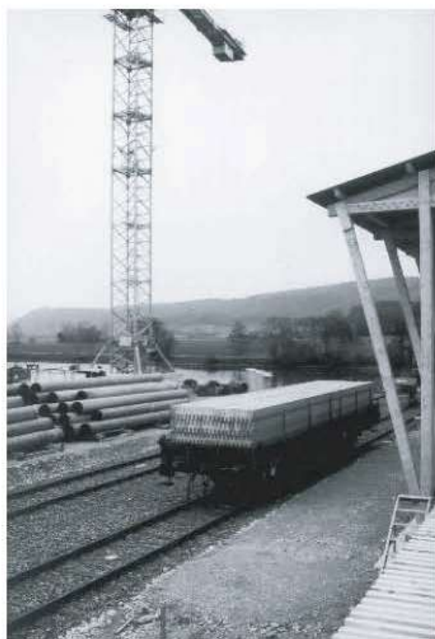
(a) Transport ferroviaire des segments de Dalle O-portune .
