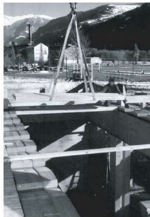
(c) Mise en place des panneaux de planches clouées entre les poutres principales dont on distingue bien les entailles.
