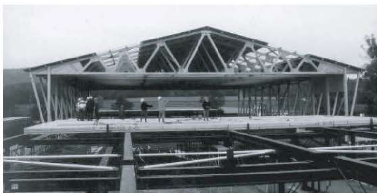
(b) Vue générale de la halle et du montage surélevé des éléments de plateforme.
