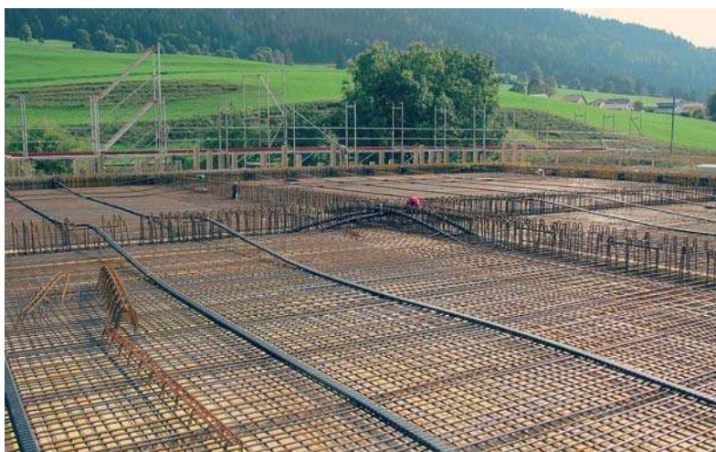
Fig. 7 Pose de la précontrainte. Installing the pre-stressing.
