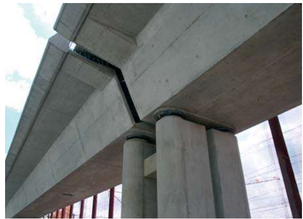
Fig. 6 Abschnittsgrenze. Expansion joint.
